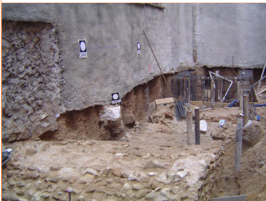
Foto 44. Treballs de documentació amb escàner 3D.
