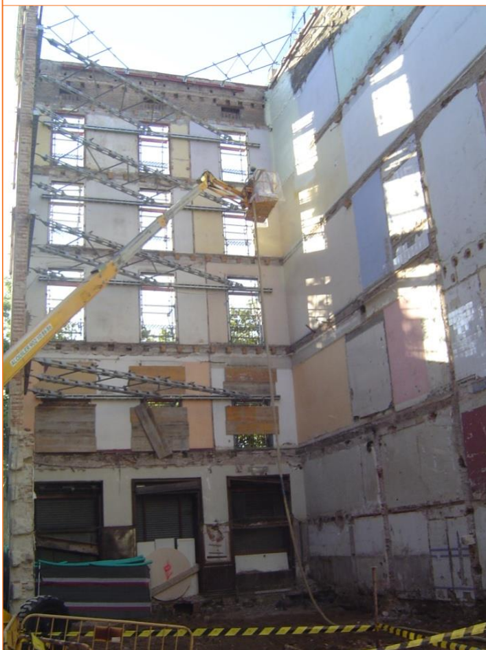
Foto 1. Vista general de les façanes conservades.
