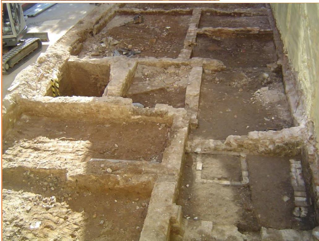
Foto 2. Vista general de murs i riostes.
